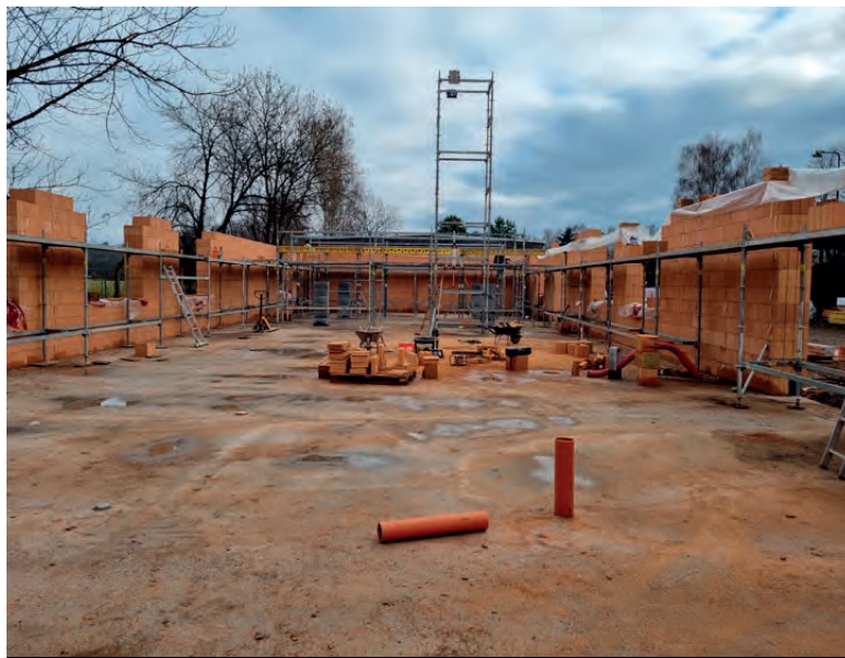
Novostavba skladového objektu. Foto archiv NHK
