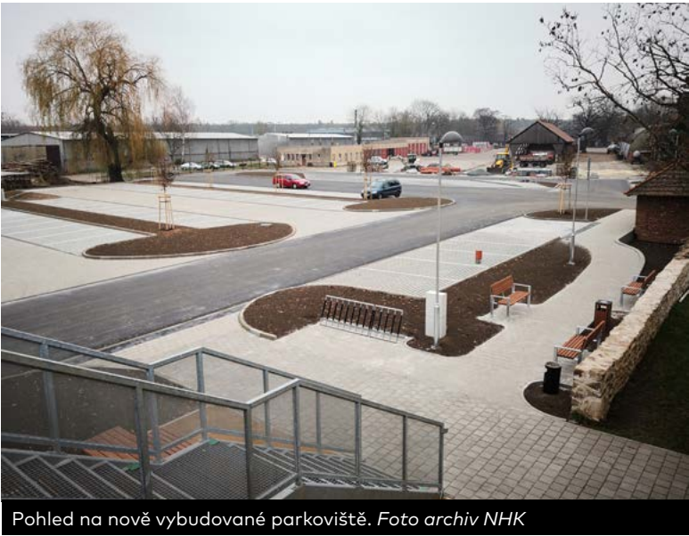
Pohled na nově vybudované parkoviště. Foto archiv NHK
